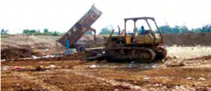
รูปที่ 4 ตัวอย่างการฝังกลบขยะมูลฝอยตามหลักสุขาภิบาล
